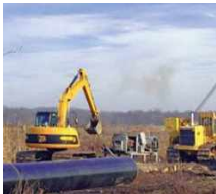
Рис. 12. Реконструкція газопроводу Рис. 13. Високовольтна ЛЕП
